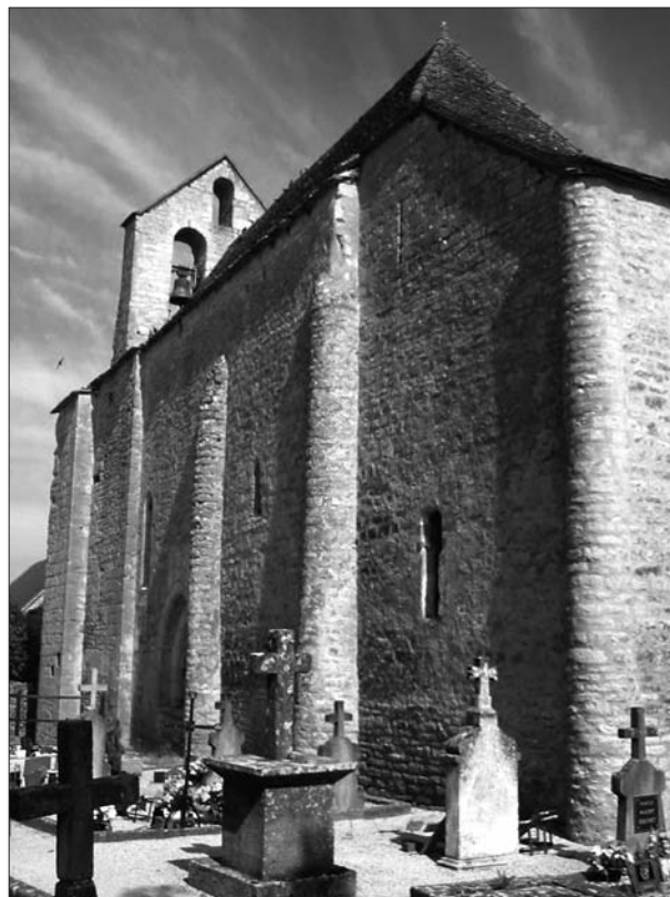
FIG. 2. ÉGLISE SAINT-MARTIN À MAYRINHAC-LE-FRANCAL, élévation extérieure sud. Cliché Valérie Rousset, 2005.
