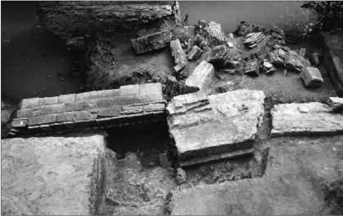
FIG. 8. L'EFFONDREMENT DE LA PILE D ET DE L'ARCHE N° 4, vue depuis le nord.
