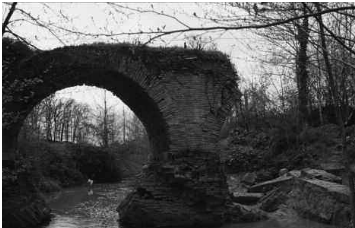
FIG. 4. LES EFFONDREMENTS DE L'ARCHE 4, vue de l'est.
