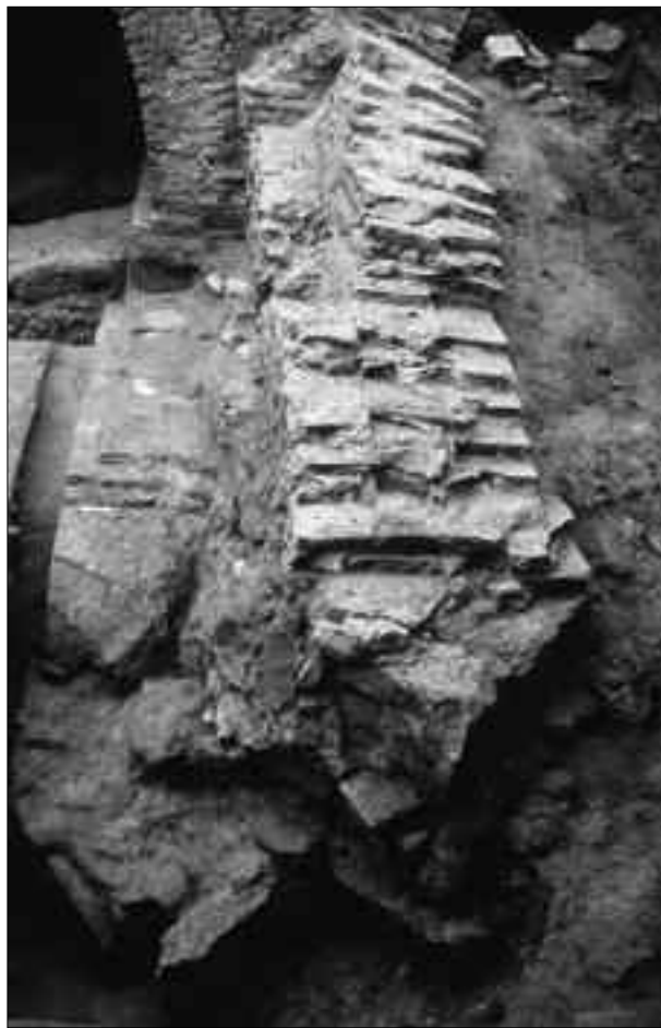
FIG. 7. ARRIÈRE BEC DE LA PILE A et départ de la voûte de l'arche 1.
