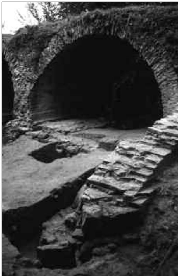
FIG. 6. DÉGAGEMENT DE LA PARTIE AVAL DE LA PILE A, sondage 2.
