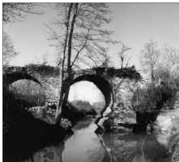
FIG. 3. ÉLÉVATION ORIENTALE avant les travaux de dégagement.
