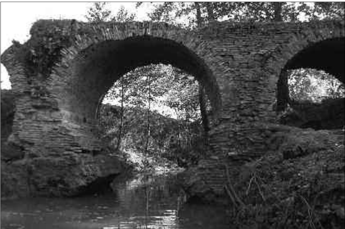
FIG. 9. ÉLÉVATION OCCIDENTALE, vue du bûchage de l'arche 3.
