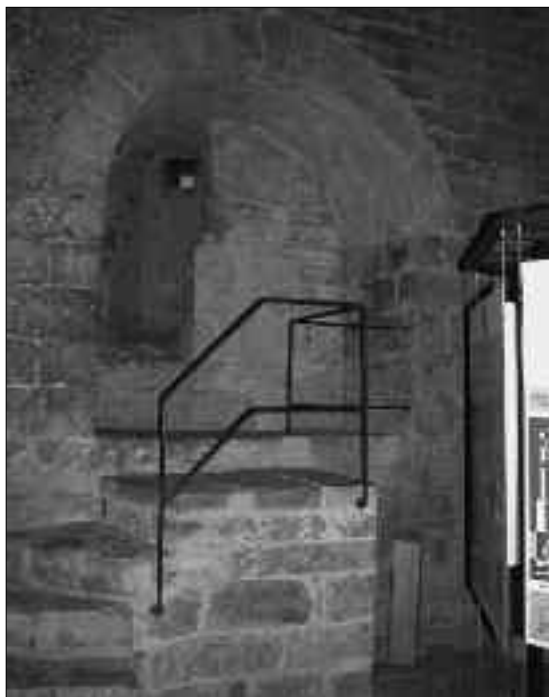
FIG. 9. VUE DU MUR OUEST DU 1 er ÉTAGE. Cliché Philippe Poitou,
