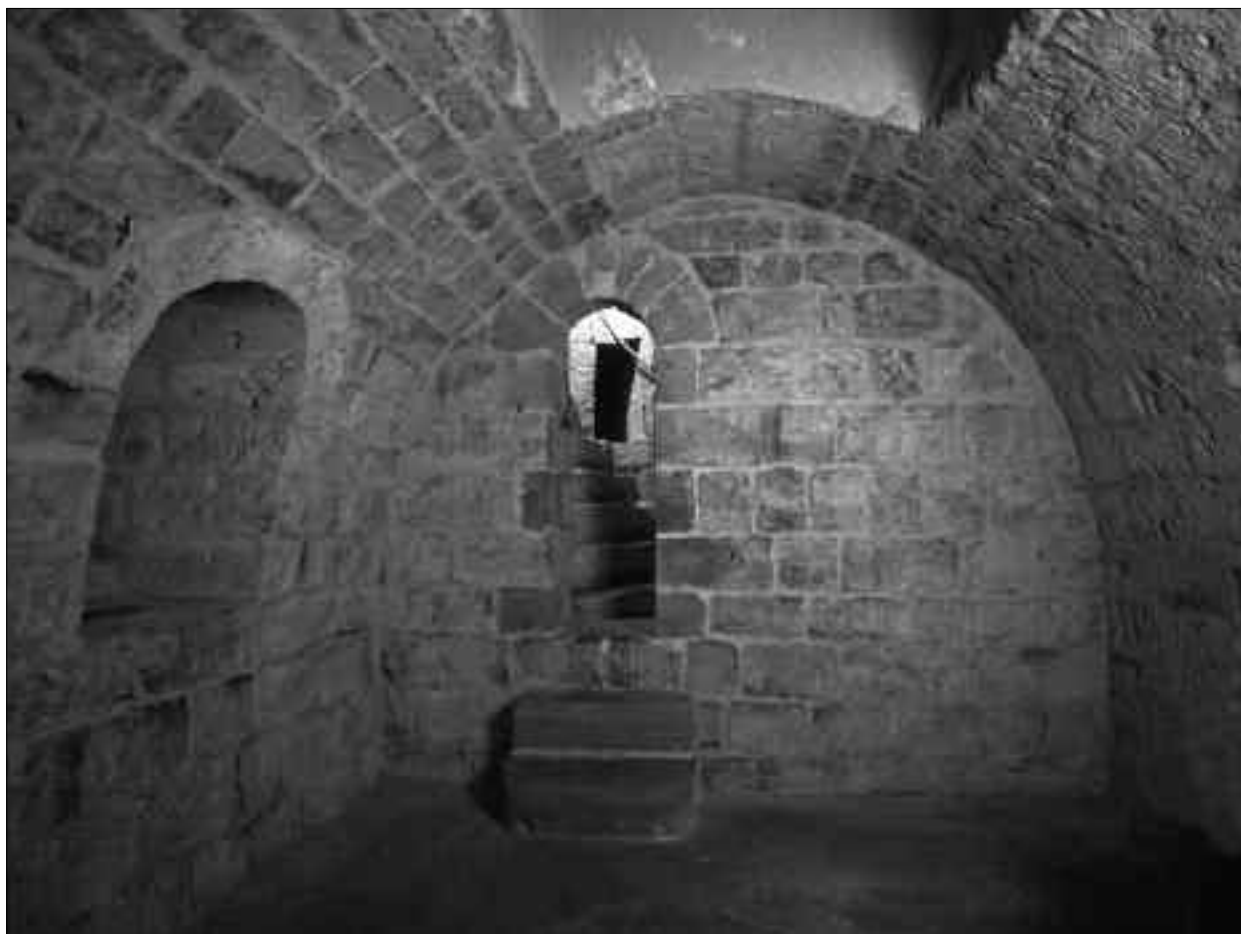
FIG. 6. REZ-DE-CHAUSSÉE, vue d'ensemble de la pièce depuis l'ouest. Cliché Pierre Plattier, Ville de Millau.
