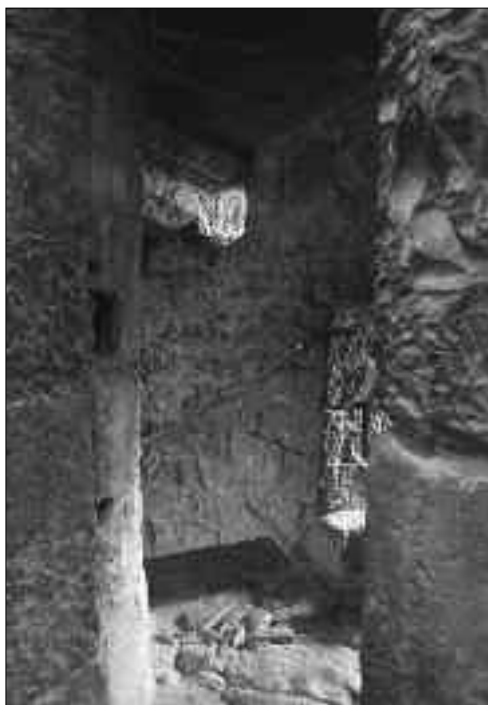
FIG. 20. PALIER DU 2 e ÉTAGE, angle sud-ouest. Cliché Françoise Galés.
