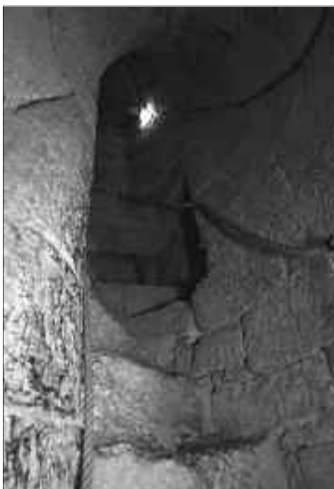
FIG. 23. ESCALIER EN VIS DITE DE SAINT-GILLES. Cliché Philippe Poitou Service Régional de l'Inventaire de Midi-Pyrénées.
