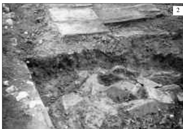
FIG. 5. 1: TOITURE EFFONDREE au-dessus du niveau du dallage. 2: TOITURE EFFONDREE au-dessous du niveau du dallage.
