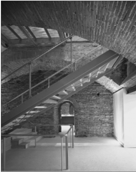
ACCÈS AU SOUS-SOL depuis le hall.
