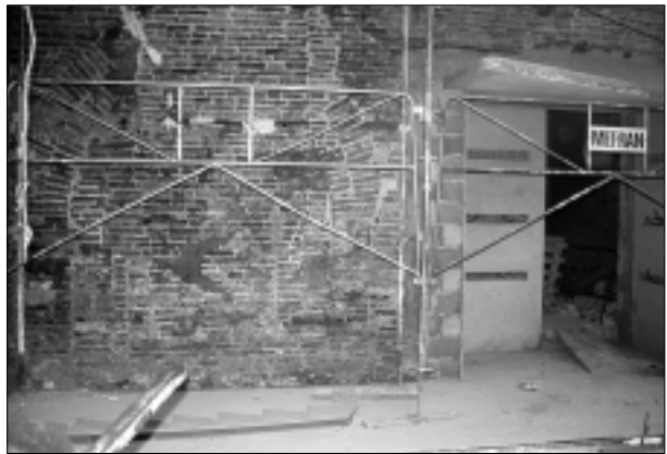
Porte médiévale (aujourd'hui masquée par l'enduit) sous la galerie du XIV e siècle, et nouvelle porte en béton.
