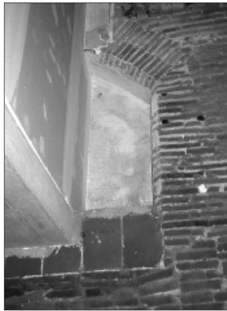
Baie médiévale du mur de refend donnant sur la chapelle recoupé par les adjonctions actuelles.
