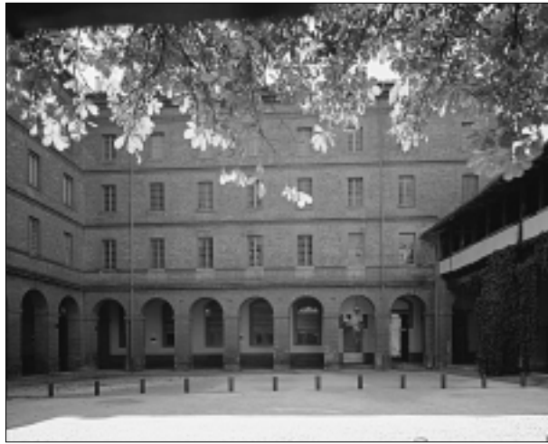
VUE D'ENSEMBLE AVEC LA COUR AMÉNAGÉE. Noter la galerie à droite.
