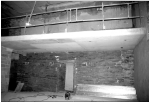
Le volume de la chapelle du collège médiéval recoupé par un plancher en béton.
