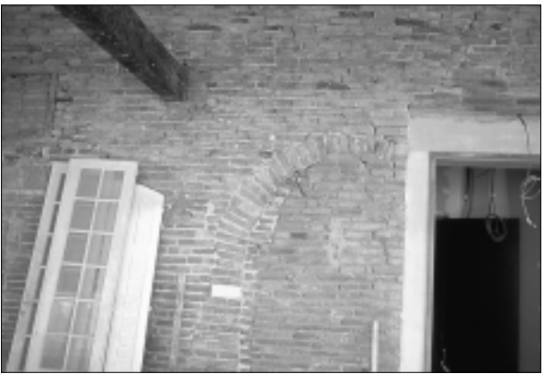
Ancienne porte et porte nouvellement percée au premier étage de la galerie.
