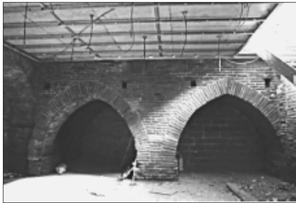
Cave de l'aile ouest sur la rue du Taur.
