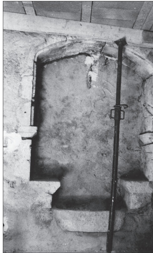
FIG. 9. CHÂTEAUNEUF-DU-RHÔNE. Rue du Portail. Maison élémentaire, premier étage. Cliché Y. Esquieu
